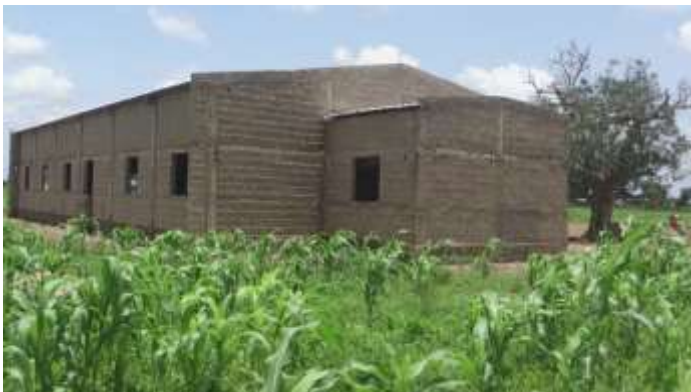
Chiesa di Ninfoagma allo stato attuale dei lavori
